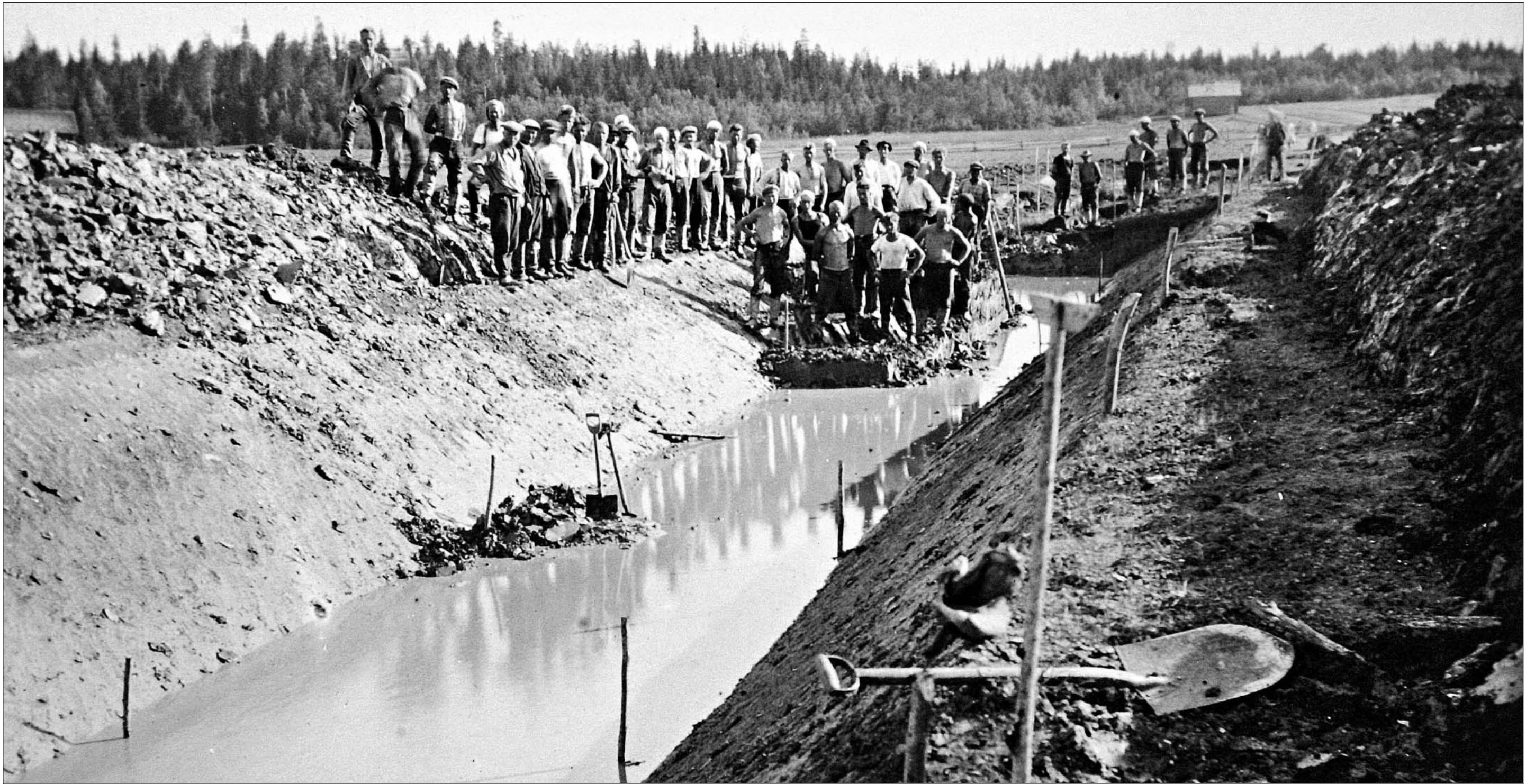
Liikkalan kylän Pekinojaa syvennettiin ja levennettiin hätäaputyönä. Työ tehtiin lapiolla ja miehiä oli Savosta saakka. Palkka työstä oli keho. Kuvan ottaja ei ole tiedossa.
